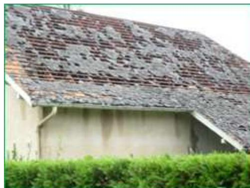
Toiture envolée à Bedous en 2010 – Toiture détruite par la grêle à Ogeu en 2009
